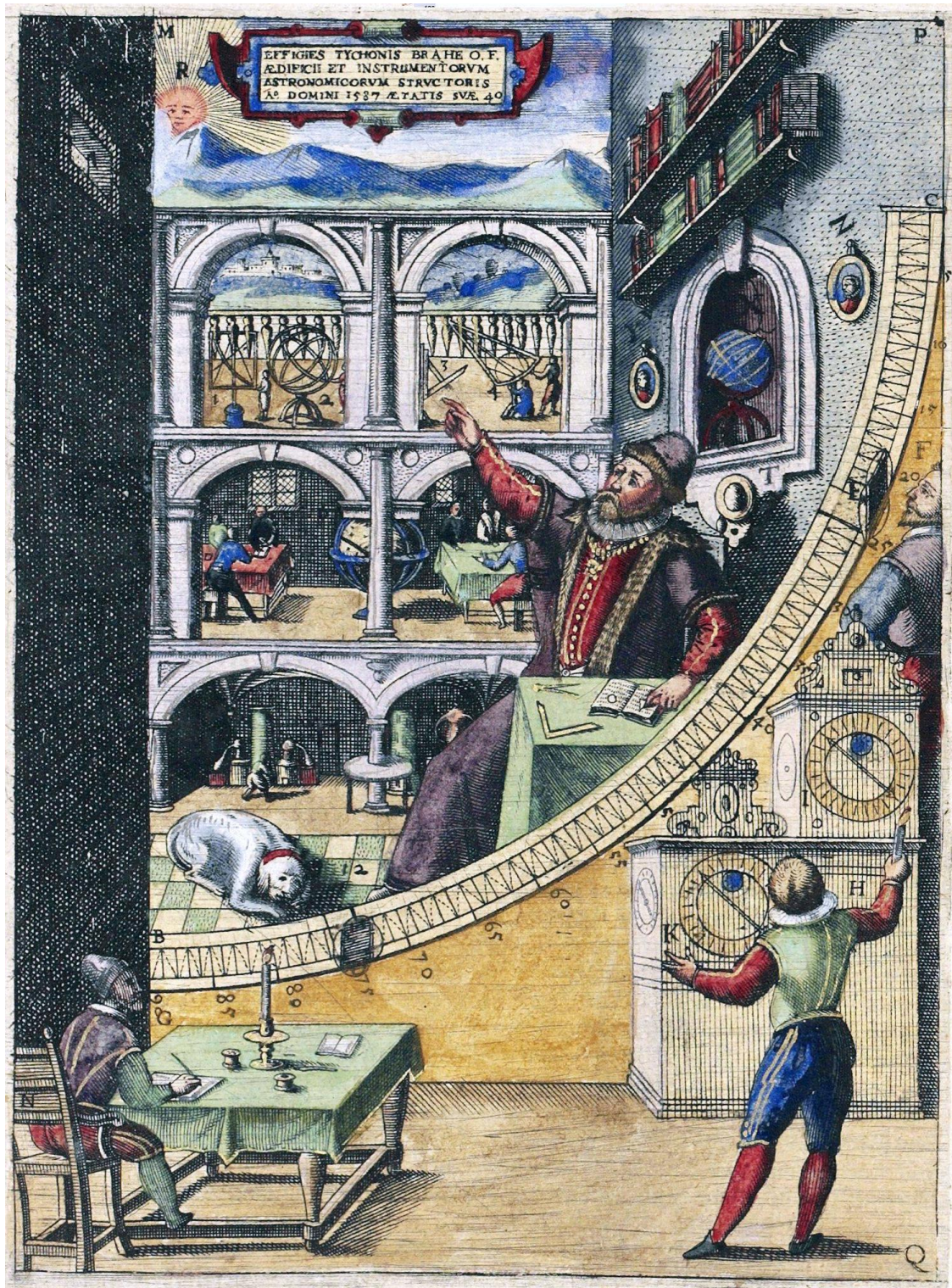
Quadrante Mural de Tycho Brahe em seu Palácio Observatório Uraniburgo. O quadrante, com raio de quase 2 metros, foi feito de latão e fixado a uma parede orientada precisamente no sentido norte-sul. Gravura do livro Astronomiae instauratae mechanica , Tycho Brahe (1598), Wandsbeck. Fonte: Exposição online The Royal Library. Crédito: Axel Boldt. In WIKIPÉDIA. Domínio Público.
